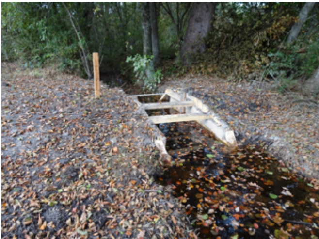
Links: Aufstau des Mostbachs mit Holzkonstruktion beim Weiher O4 im Oberhöflerriet. 13.10.2022. Foto Max Trafelet. Rechts: Der Aufstau wurde bei einem späteren Grabenunterhalt etwas verbreitert. 11.10.2023
