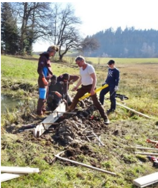
Am einem neuen Gewässer nördlich vom Cheibenrietli (Ambitzgi/Böndlerriet) wurde der Damm von Xavi Jutz und Zivis erhöht und mit Spundwandbrettern abgedichtet. 03.03.2025. Foto Max Trafelet. Damit wurde die geplante Weiherfläche erreicht. Der Algenbewuchs deutet auf ausgeschwemmte Nährstoffe aus der ehemals gedüngten Wiese. Foto vom 23.04.2025.
