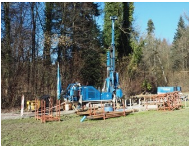
Um die geologischen Verhältnisse abzuklären, wurden im Zusammenhang mit der geplanten Oberland-Autobahn an verschiedenen Stellen der Druzo Sondierbohrungen durchgeführt. Letzte Bohrung am Amslenbüel. 28.02.2025. Foto rechts: Max Trafelet
