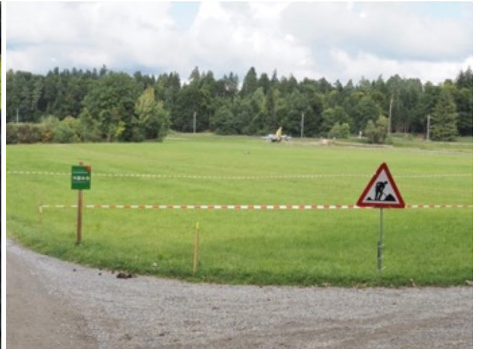
Projektfläche A kurz nach Baubeginn.
