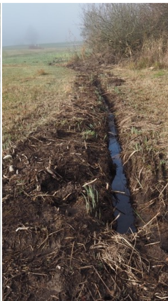
Links: Marcel Hatt protokolliert den Zustand von Graben und Stauwehr im Schweipelriet. Hier besteht kein Unterhaltsbedarf. Rechts: Diese Grabenstrecke im Freecht ist stark verwachsen. Deshalb ist eine Teilräumung in Handarbeit angesagt.
