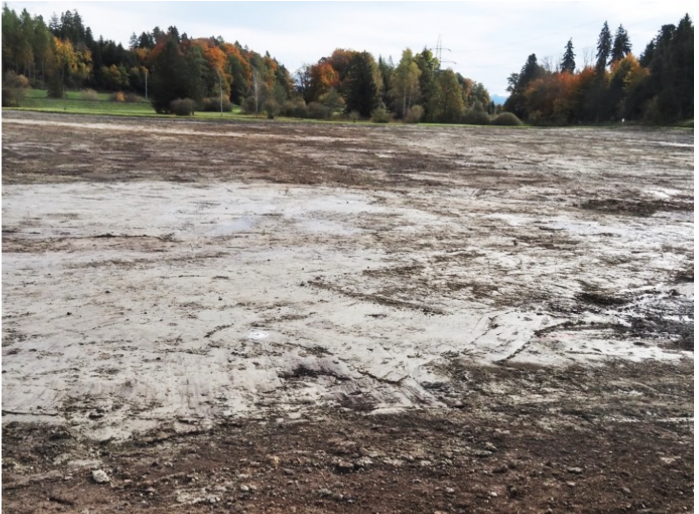
Auf der Teilfläche A ist der Oberboden vollständig abgetragen und abtransportiert. Der magere, teils lehmige Grund ist vorbereitet für eine Direktbegrünung mit Saatgut und gezielt gesammelten Samen aus Streuwiesen der Region. Es sollen verschiedene Feuchtwiesentypen entstehen. Das Relief ist so gestaltet, dass sich das Streuland maschinell möglichst problemlos bewirtschaften lässt. 21.10.2025
