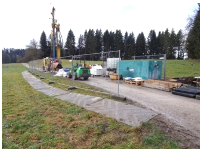
Um die geologischen Verhältnisse abzuklären, wurden im Zusammenhang mit der geplanten Oberland-Autobahn an verschiedenen Stellen der Druzo Sondierbohrungen durchgeführt. Letzte Bohrung am Amslenbüel. 28.02.2025. Foto rechts: Max Trafelet
